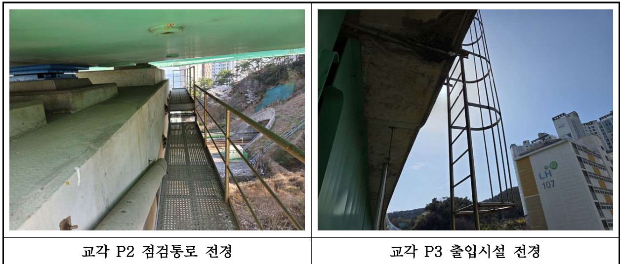
【사진 3.3.26】 교량 점검시설 전경
