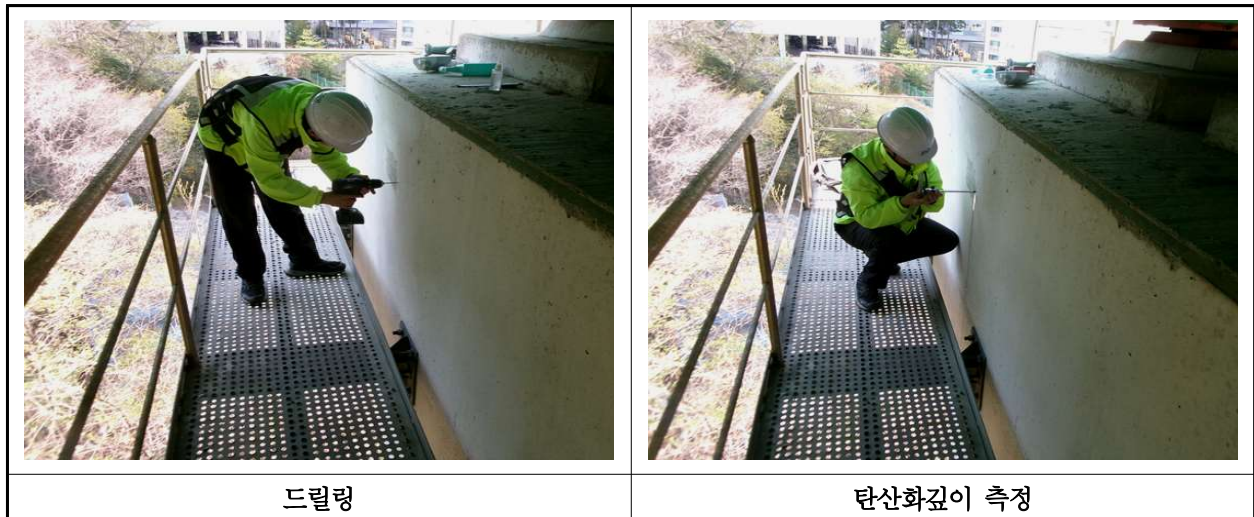
【사진 3.4.3】 탄산화 깊이 측정 현장사진
