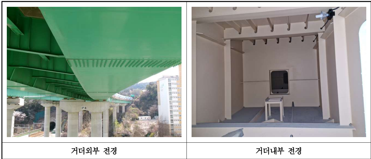
【사진 3.3.4】 거더 전경
