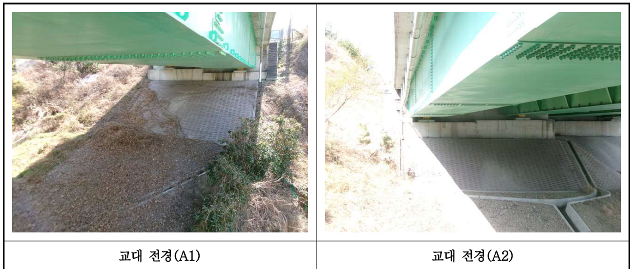
【사진 3.3.8】 교대 전경
