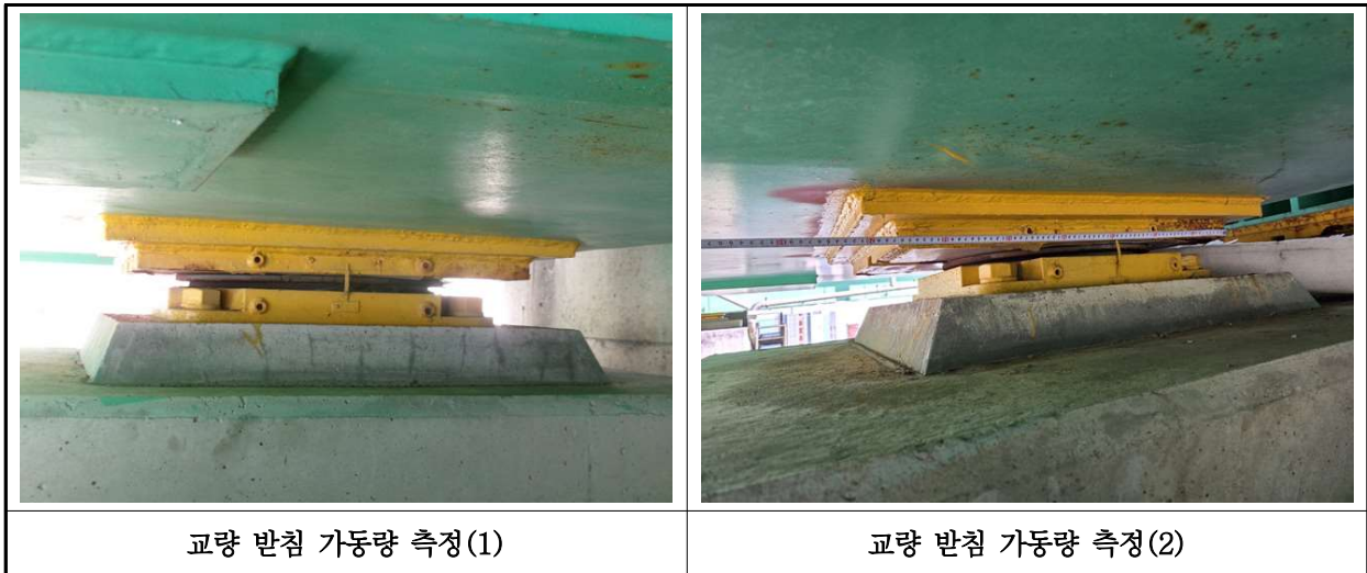
【사진 3.3.16】 교량받침 이동량 측정
