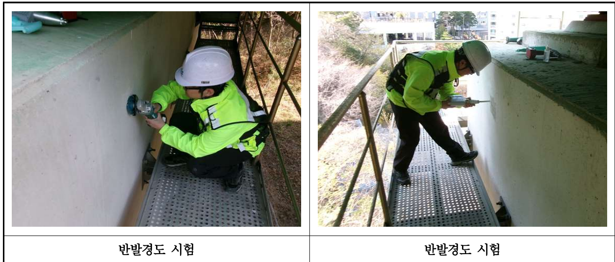
【사진 3.4.2】 반발경도시험 현장사진
