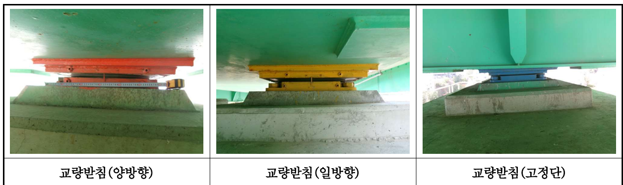
【사진 3.3.13】 교량받침 전경
