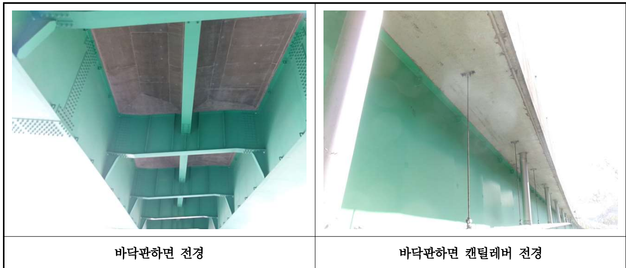
【사진 3.3.2】 바닥판하면 전경
