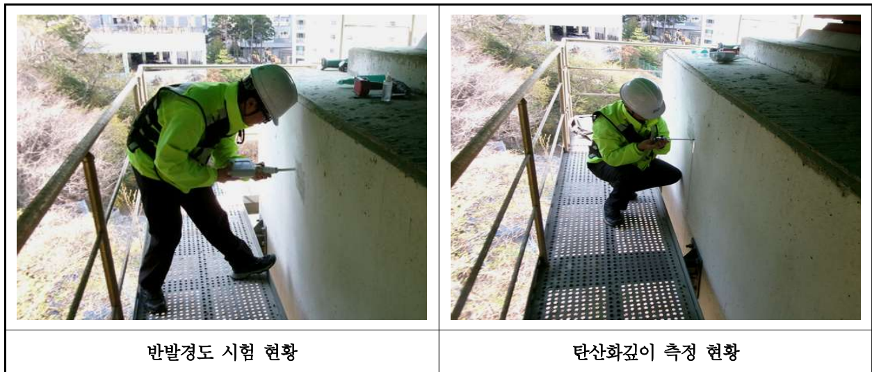
【사진 3.4.1】 콘크리트 내구성조사 현황
