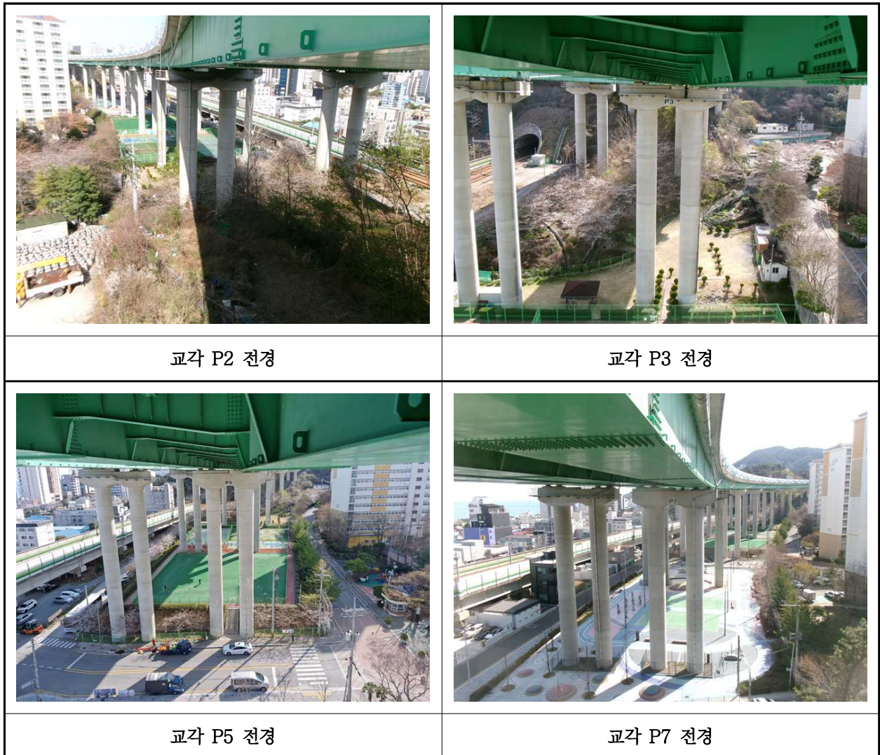
【사진 3.3.10】 교각 전경
